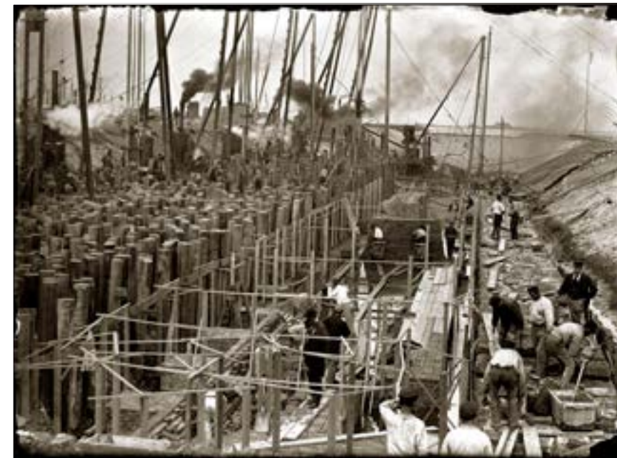
Heien van de funderingen voor de graansilo (de eerste in Nederland) van de firma Korthals Altes bij de Van Diemenstraat. Ontwerp van het ruim 100 m. lange gebouw: J.F. Klinkhamer (1854-1928). Jacob Olie (1834-1905), 1896. SAA, Collectie Jacob Olie Jbz., afb. 10019A001215
