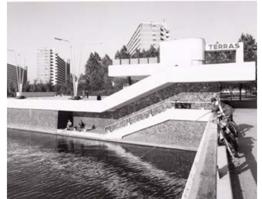
Terras van Schip van Slebos, Oostoever 1 aan de Slotterplas. J.M. Arsath Ro's, 1972. SAA, Collectie Stadsarchief Amsterdam: foto's eigen fotodienst, alfb. 010122005726. Het Schip van Slebos, een betonnen terras aan de oostoever van de Slotterplas, Amsterdam West. Dit speelse gebruiksonderdeel van de openbare ruimte, dat Dick Slebos in 1955 ontwierp en in 1961 werd uitgevoerd, herinnert in zijn contour aan een kunstvaartschip met hoog achterkasteel en drie laadmasten. Enige discussie ontstond rond een prijsvraag die het stadsdeel uitschreef voor doorontwikkeling van de locatie tot hotel-restaurant. Het winnende ontwerp van Bergevoet Architecten, i.o.v. Heren2 projectontwikkelaars, brengt een toren aan voor een 120 kamers tellend hotel. De discussie over aantasting van het monument verstomde toen Bergevoet erop wees dat In Dick Slebos' oorspronkelijke ontwerp ook in een – nooit gerealiseerde – hoge toren voorzag.
