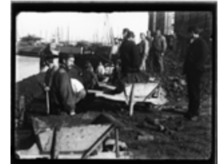
Houtmankade, gezien naar brug nr.346 tussen Tasmanstraat (links) en van Diemenstraat(rechts). Links het Westerkanaal, links achter het Volkskoffiehuis. Jacob Olie (1834-1905), 1896. SAA, Collectie Jacob Olie Jbz., afb. 10019A000598.
